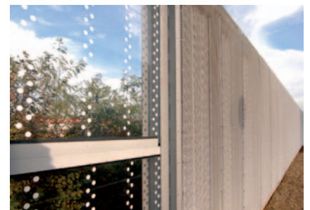
Lärmschutzwände erstrecken sich über die gesamte Länge der Nordseite der neuen Umgehungsstraße und punktuell auf der Südseite.
