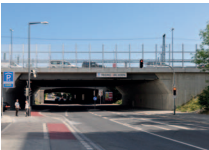
Die Brücke über die Offenbachstraße konnte ohne Beeinträchtigung des Verkehrs gebaut werden.
