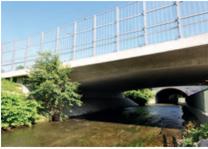
Die neue Brücke über die Würm
